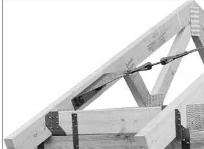
Detail am Traufpunkt: Bandanschluss BNG25 und Spanngerät BNSP25 mit Bolzen M12 durch den Sparren befestigt. In gleicher Weise kann der Bandanschluss BNG25 an Betongiebeln gehalten werden.
