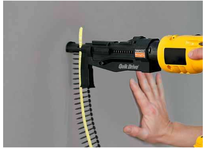
Montage einer Gipskartonplatte an Holzständerwerk mit DWC-Schnellbauschrauben
