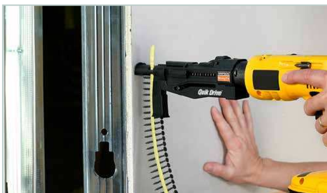
Montage von Gipskartonplatten auf Metallständerwerk
