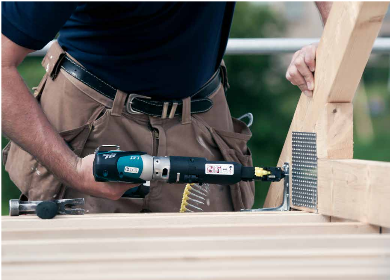
Montage eines ABR90 Winkelverbinders mit Quik Drive® Magazinschraubensystem. Weitere Holzverbinder finden Sie in unserem Profikatalog oder unter strongtie.de .
