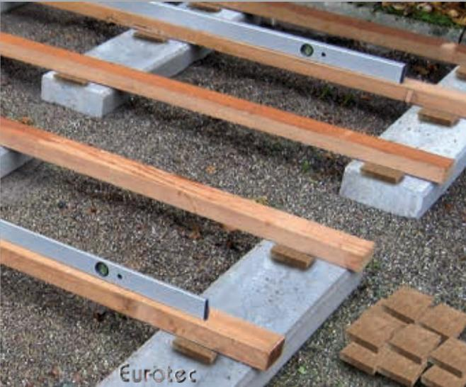
Die Kork-Pad Abstandhalter werden zwischen die Terrassenunterkonstruktion und das Fundament/den Untergrund gelegt und bilden so einen Abstand, der dem konstruktiven Holzschutz dient. Die Kork-Pad Abstandhalter stehen in drei Größen zur Verfügung. Diese sind 3 mm, 6 mm und 10 mm Stärke/Höhe (siehe Abb.).
