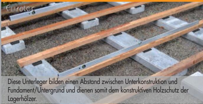
Diese Unterleger bilden einen Abstand zwischen Unterkonstruktion und Fundament/Untergrund und dienen somit dem konstruktiven Holzschutz der Lagerhölzer.
