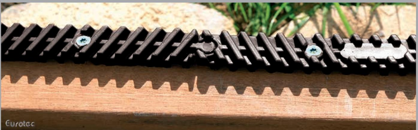
Die Dista-Leiste wird halbseitig auf die Unterkonstruktionshölzer aufgeschraubt. So wird das nochmalige Durchschrauben der Leiste vermieden, wenn die Terrassendielen verlegt werden. Bei breiteren Traghölzern ist es zu empfehlen die Dista-Leiste abwechselnd rechts und links halbseitig zu befestigen, damit die Terrassenschraube beim Befestigen der Dielen nicht das Tragh Holz einseitig in Richtung der Diele zieht und somit kippt.
