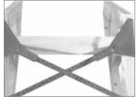
Detail am Firstpunkt: Bandanschluss BNF mit zwei Kopplungsverbindern BNKK. Sparren gegen Kippen durch Verblockung gesichert.
