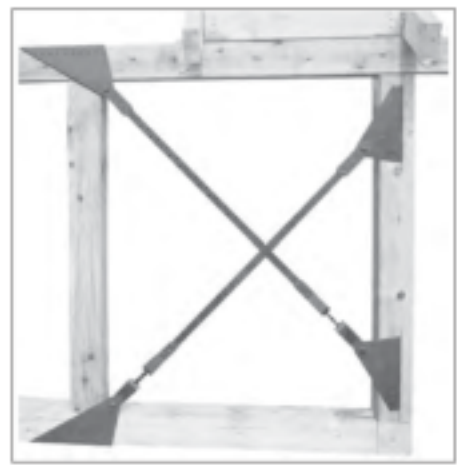
Wandaussteifung mit Bandanschlüssen BNG oder BNF
