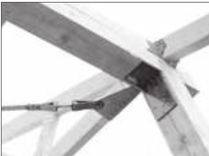
Detail am Traufpunkt: Bandanschluss BNF mit Spanngerät BNSPxxB. Von unten in Deckenebene.
