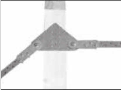
Detail am Firstpunkt: Bandanschluss BNF mit zwei Kopplungsverbindern BNKK.
