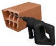
1. Bohrloch erstellen
